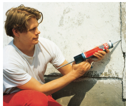
Trhliny v omietke sa dajú plasticko-elasticky vyplniť s PCI Adaptol.
