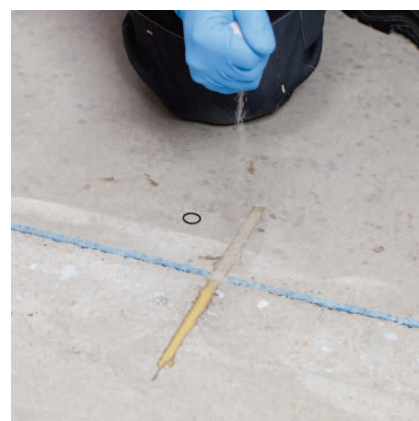
Povrch zahľadiť a v prípade potreby posypať celoplošne kremičitým pieskom so zrnitosťou 0,3 - 0,8 mm.
